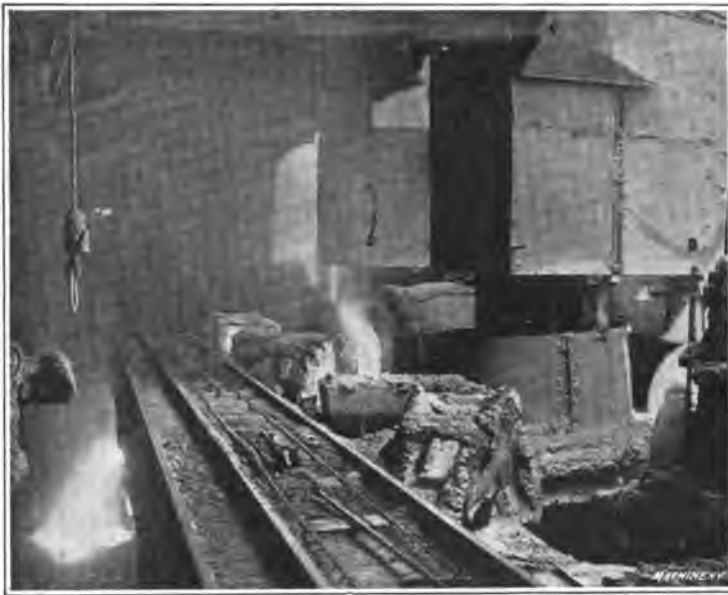
Fig. 2. A Bessemer Converter Pouring
